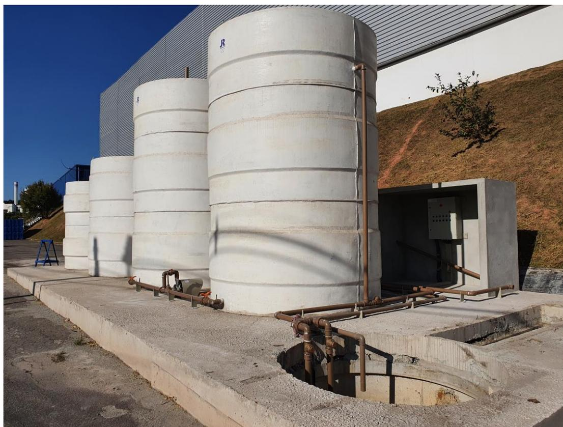
A imagem acima mostra um sistema de tratamento aeróbio de esgoto em fase final de instalação
